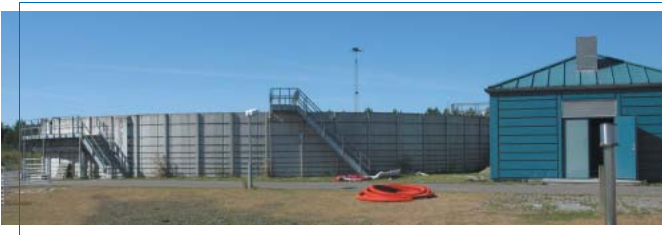
Forrenseanlæg / Pre-treatment plant
